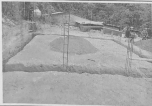
Foto 3: Colocación de hierro para las columnas.
