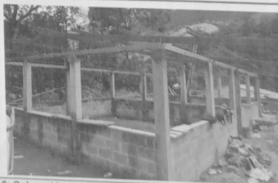
Foto 6: Colocación de la estructura.
