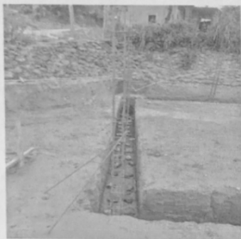
Foto1: Realización de cimiento en el lado derecho.
