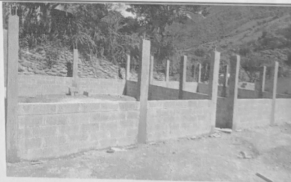
Foto 4: Vista frontal con las columnas fundidas.
