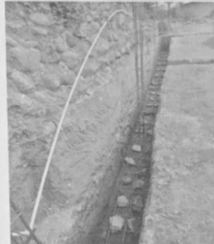
Foto 2: Realización de cimiento de la parte de atrás.
