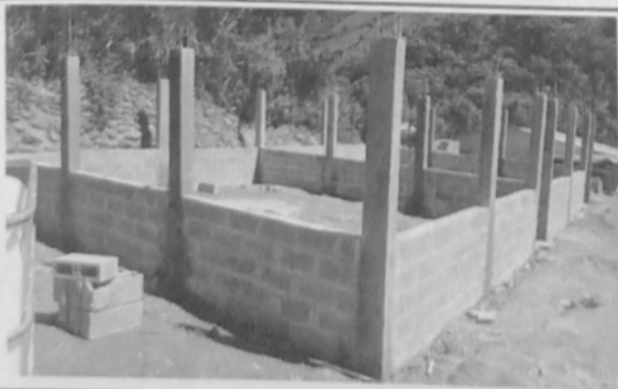
Foto 5: Finalización del pegado de block y columnas.
